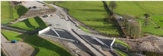
Iarnród Fhainge go Luimneach, Droichead Iarnróid RB03 – Ard an tSeabhail Áth Dara
