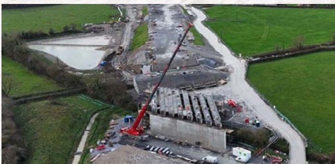
Radharc ar Chéanna Lár-Oirthear Dhroichead na Máighe (RVB04) ag féachaint siar. Tabhair faoi deara pliontaí a caitheadh ar a bharr mar ullmhúchán do shocrúchán giarsa cruach i Ráithe 2 2026.
