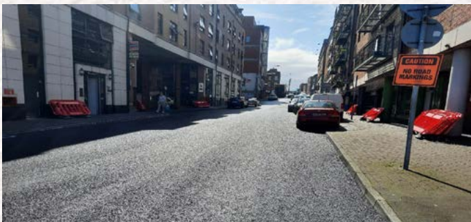
Scéim athdhromchlaithe Bhóthar Mhoín Cinit ina bhfuil forleagan macadam, a sheachadtar mar chuid den chlár ilbhliantúil athdhromchlaithe bóthair
