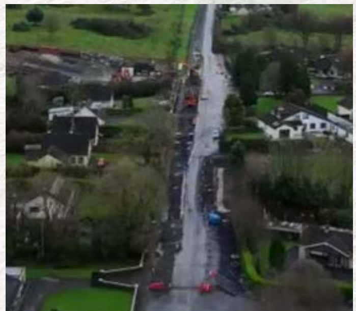
Tá tús curtha le hoibreacha ar shuiteáil an tséaraigh bréan agus stoirme ar Bhóthar Cratloe
