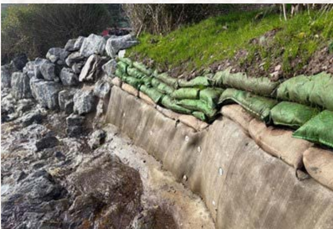
Cobhsú Teannta an Chlaifóirt agus an Droichid tar éis tuilte
