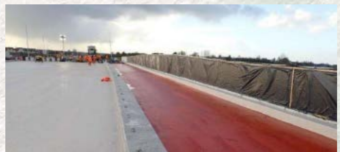
Tá uiscdhionadh Dheic an Droichid ar Droichead Bhaile Uí Dhroighneáin críochnaithe agus an chuid eile d'oibreacha an Droichid le críochnú i Ráithe 1 2026
