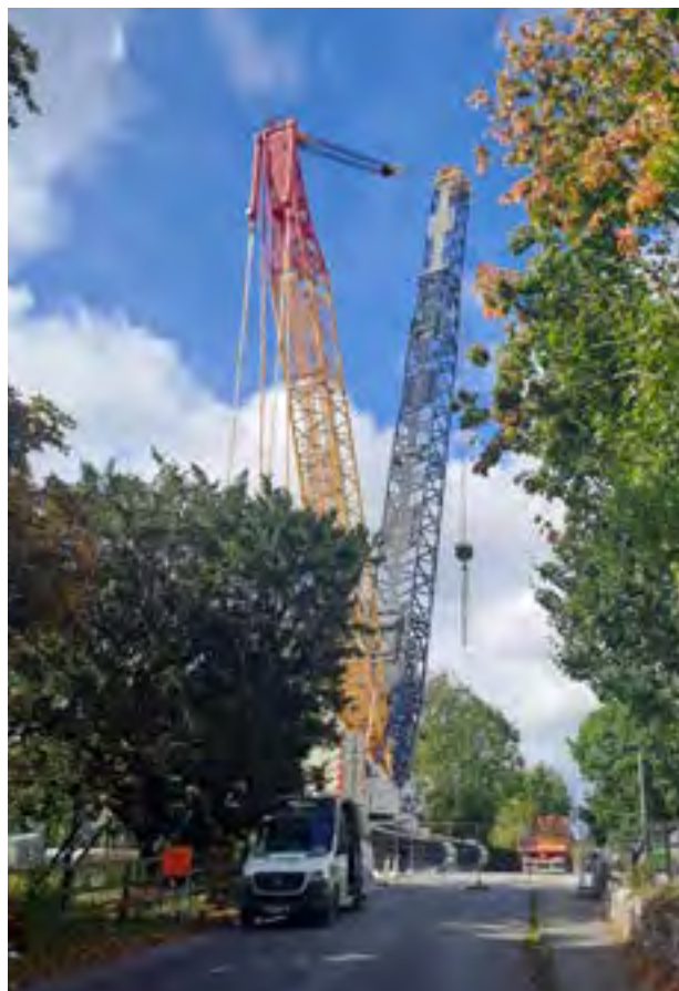
Búmchraein Ráillí Laitíse 600 tona agus Droichead Áth Dara Athchóirithe á athshuiteáil
