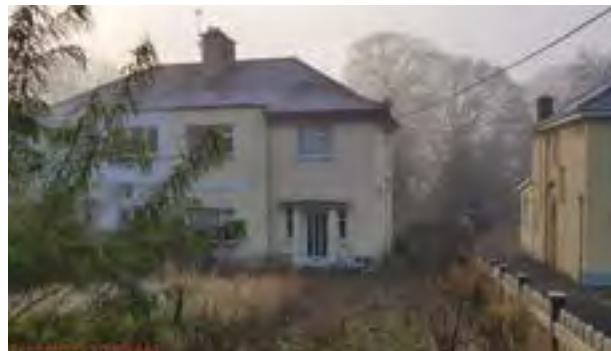
Na Goirt Thiar, An Cuarbhóthar Thuaidh sular tosaíodh ar na hoibreacha
