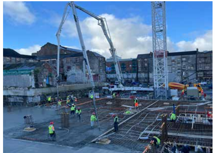
Opera Square Basement Slab – Concrete Pour
