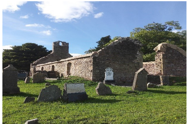
Oibreacha ag Reilig Chill Fhionáin (tar éis)
