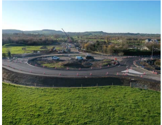
Oibreacha tógála ag Scéim Feabhsúcháin an N24 Beary's Cross
